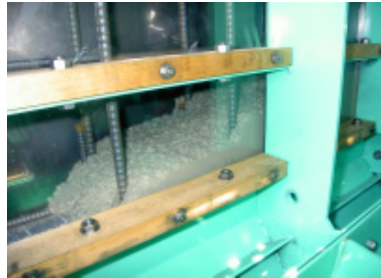
写真-2 ウェブ部充てん状況
