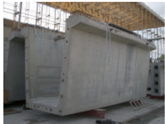
写真-3 供試体状況（第5ブロック）
