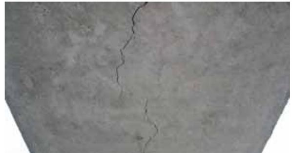
写真-3 底面のひび割れ発生状況 (H-A)
