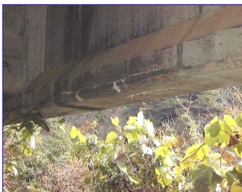
写真-1 ポストテンション T 桁橋の損傷例
