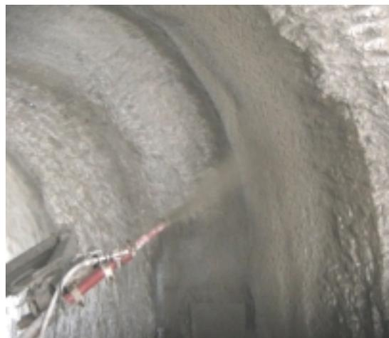
図-4 複合急結剤を用いた吹付け状況
