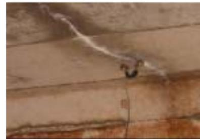
図-2 計測対象ひび割れ
