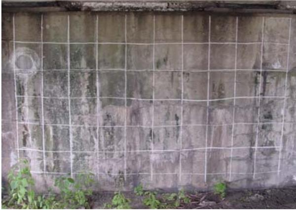
写真-1 損傷を受けたコンクリート面
