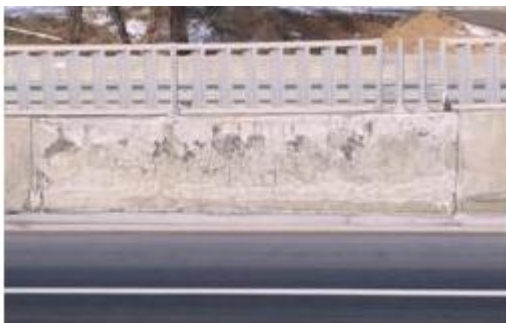
写真－1 実際に凍害を受けた韓国の構造物
