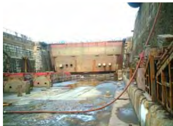
写真 - 1 ドックの外観（止水壁方向）
