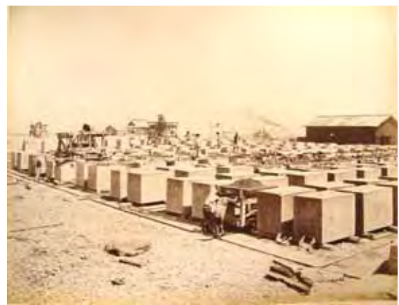
写真 - 3 コンクリートブロックの製造 （函館どつく社提供）
