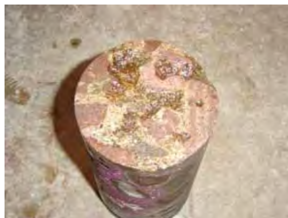
写真 - 5 コンクリートの表面状態（渠底部）
