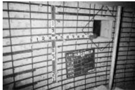
写真－１ 脚壁内の補強状況
