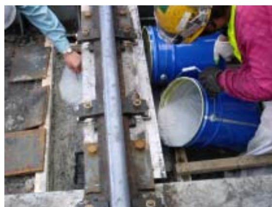
図 - 11 コンクリートの流し込み状況
