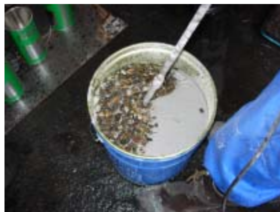
図 - 10 材料調製の作業状況
