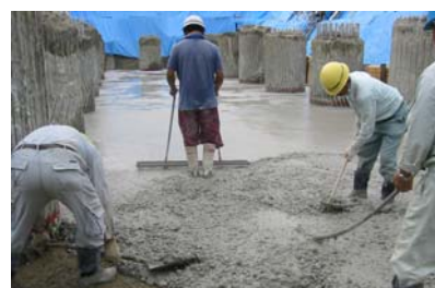
写真－3 打設状況
