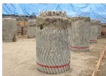
写真－１ 杭頭余盛りコンクリート
