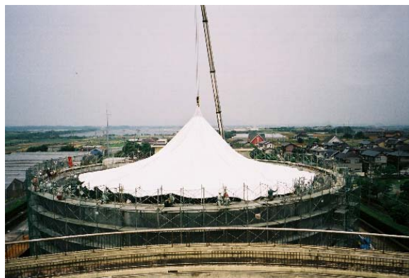
写真－6 エアドーム工法膜材の取付け
