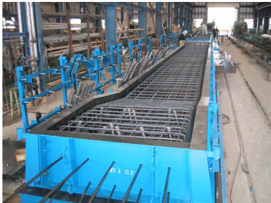
写真－1 標準部材型枠
