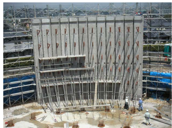
写真-3 側壁部材の建て込み状況
