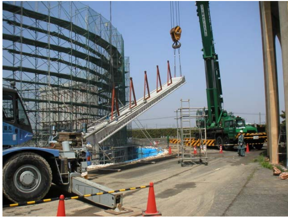
写真-2 部材の建て起こし
