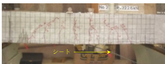
写真-2 シート剥離（側面）
