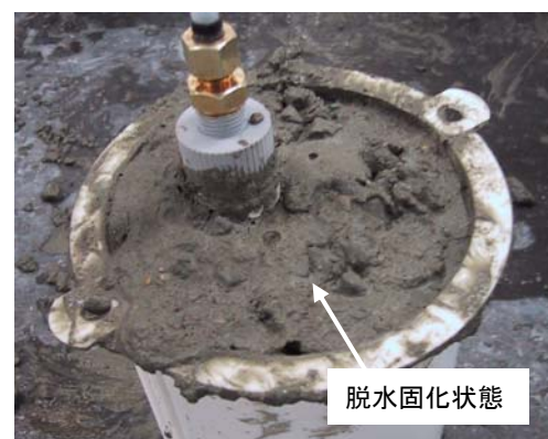
図-5 脱水されたコンクリートの表面状態
