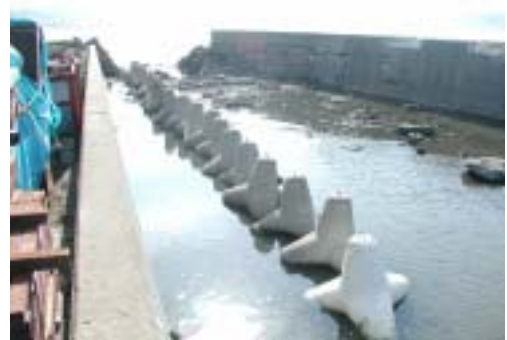
写真-1 網走港暴露コンクリート
