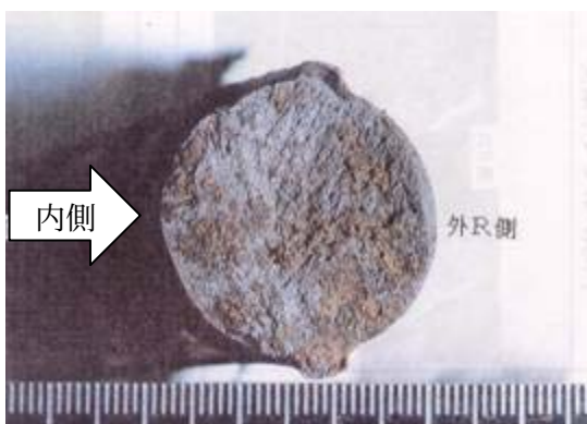
写真-2 鉄筋破断面
