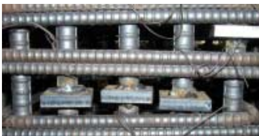
図 - 2 プレート取付状況
