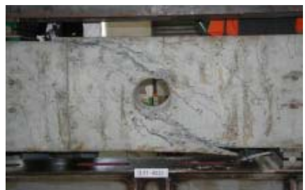
写真-2 最終破壊状況（シリーズ：21-HS32）
