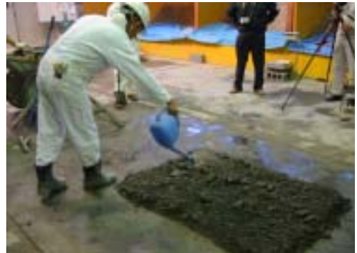
写真－１ ２次混合水散布状況
