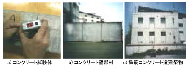
写真－3 ひび割れ幅の主な測定対象物
