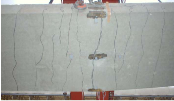
写真-1 ひび割れ(普通骨材)
