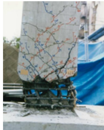
写真-1 RC 柱試験体の交番載荷終了後の状況
