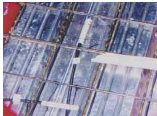
写真-1 埋込みひずみ計設置状況
