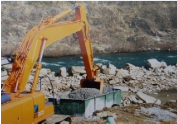
図-1 バックホウを用いた荷卸しの例
