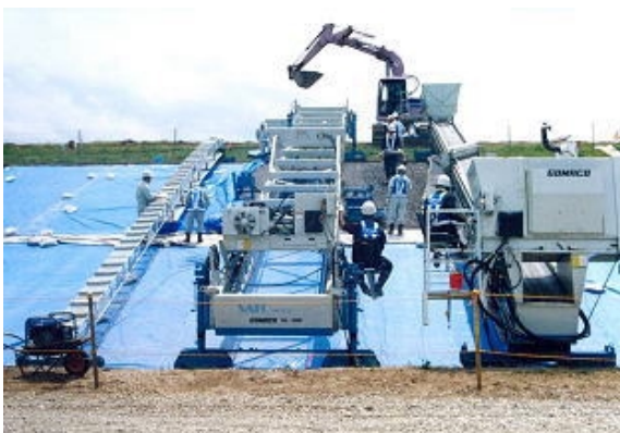
図-2 自動化された施工の例
