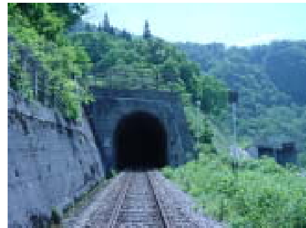
写真－3 トンネルの外観
