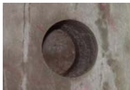
写真－１４ コア採取後の状況
