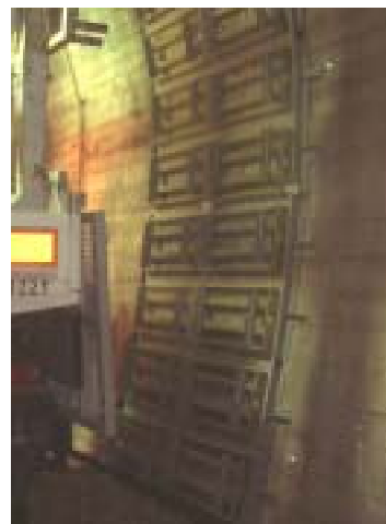
写真-10 組上がり状況
