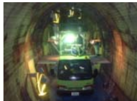
写真－7 軌陸車を用いた移動足場
