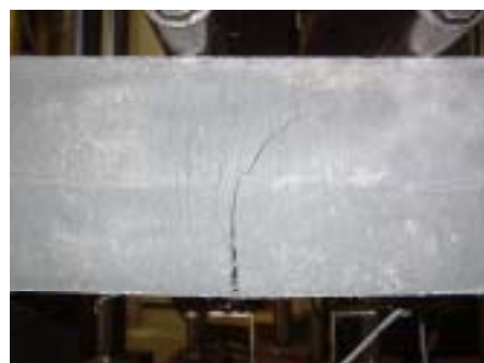
写真-2 ひび割れ状況
