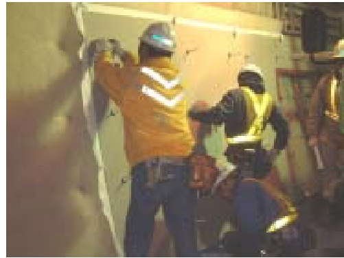
写真-9 短繊維補強ボード取付け状況
