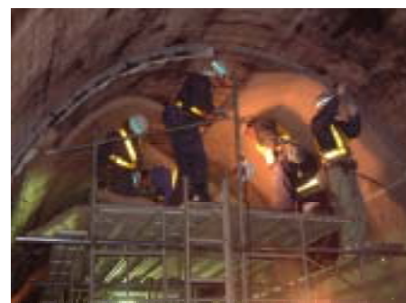
写真－8 PVA 繊維マット取付け状況
