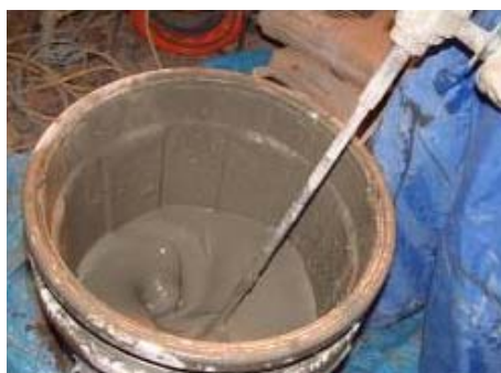
写真－6 練混ぜ状況
