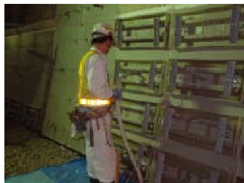
写真-11 グラウト注入状況
