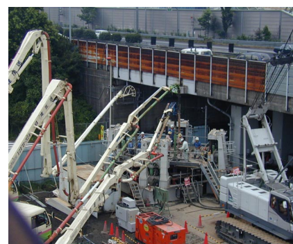
写真－3 コンクリート打設状況
