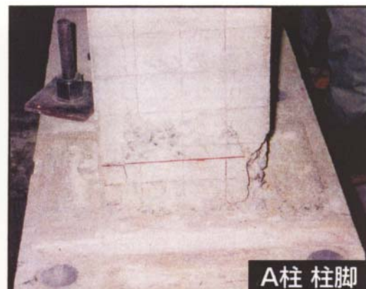
写真-4 A柱の柱脚部（筋かい付きフレーム）
