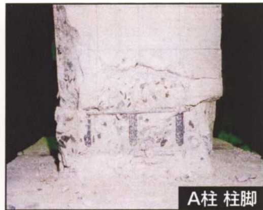
写真-2 A柱の柱脚部（門型フレーム）
