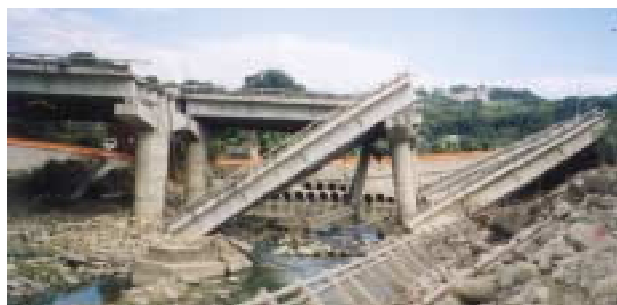
写真－１ 石圍橋の被害状況
