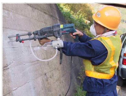
写真－１ ドリル法による試料採取状況
