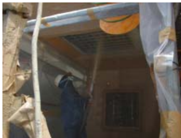
写真 - 3 吹付け状況
