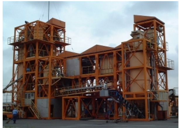
写真 - 1 加熱すりもみ法設備
