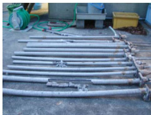
写真-1 シース管除去後の PC グラウト
