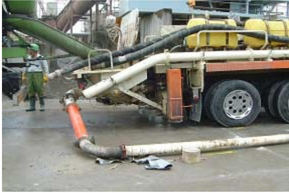
写真-1 コンクリートの圧送状況
