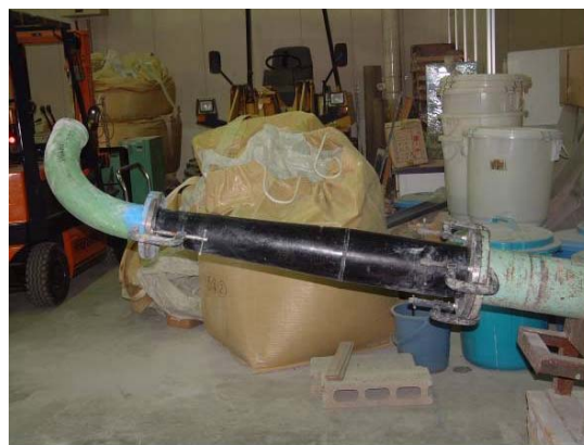
写真－１ ベント管取付状況
