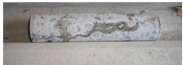
図－3 採取コア状況(横2連 30mブロック外外壁)
