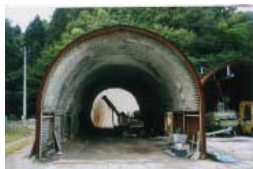
写真 - 1 模擬トンネル全景
