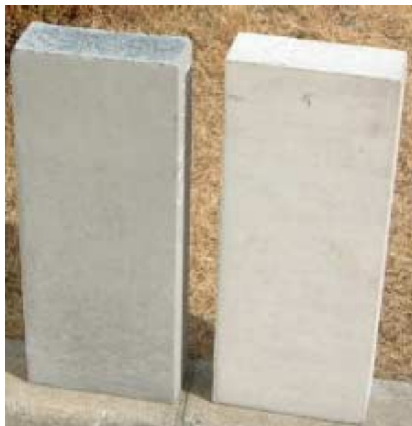
写真-5 界面活性剤 Sa10 の有無によるフライアッシュ使用コンクリート肌面の違い (左 Sa10 無添加, 右 Sa100.1kg/m 3 添加)
