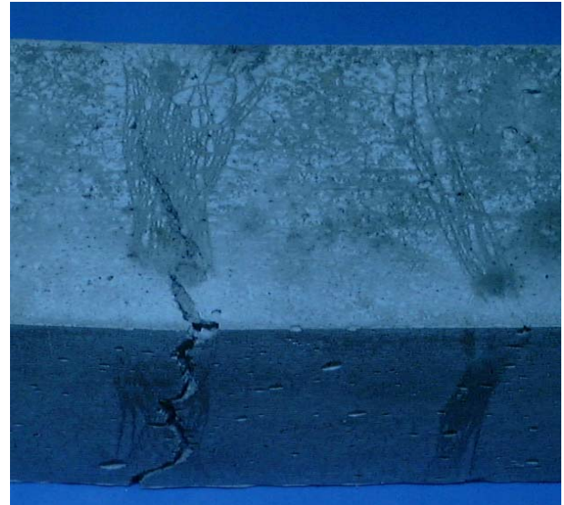
写真 - 2 ひび割れ状況：PE繊維系
