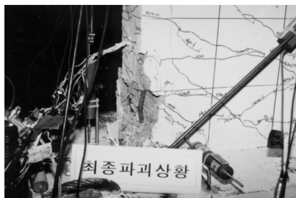
図-3 試験体破壊状況
