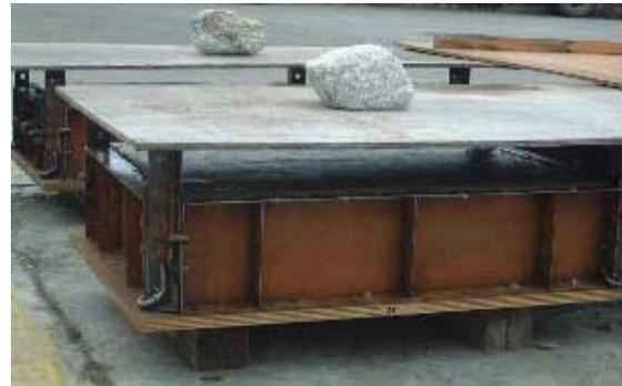
写真-3 打込み終了後の養生状態
