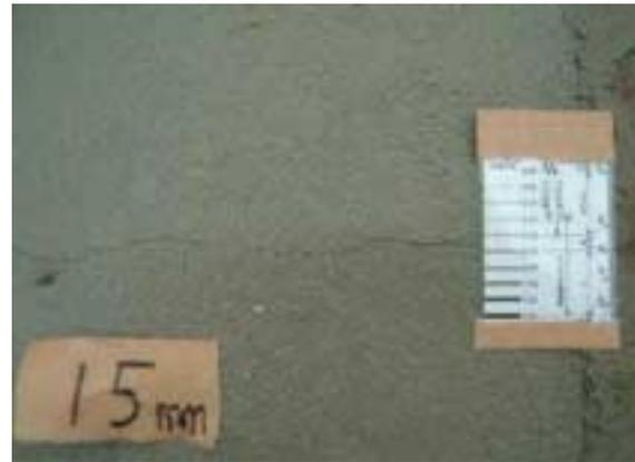
写真-4 クラックスケールと沈下ひび割れ
