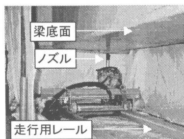
写真-1 梁底面はつり状況
