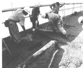
写真-2 打設状況
