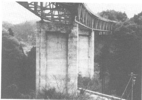
写真-1 豊川橋橋脚の全景(補強前)
