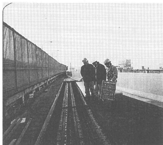
写真-4 縦目地伸縮装置の施工状況2
