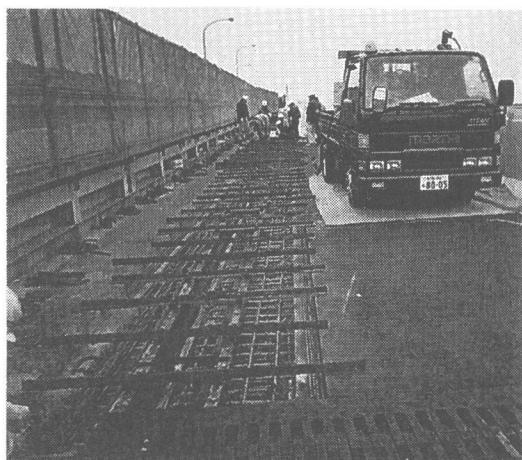
写真-3 縦目地伸縮装置の施工状況1
