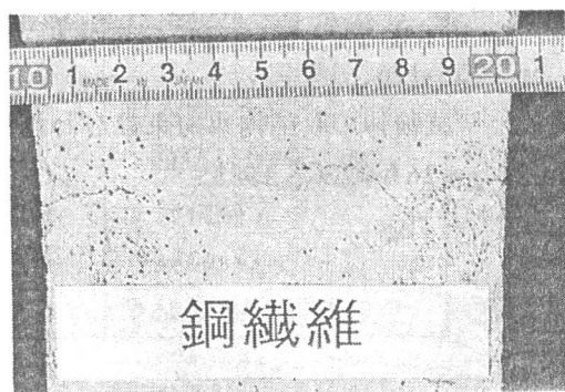
写真-3 ひび割れ状況 (鋼繊維)
