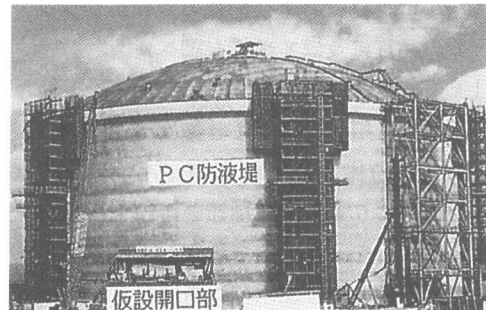
写真-1 建設中のPC LNGタンク
