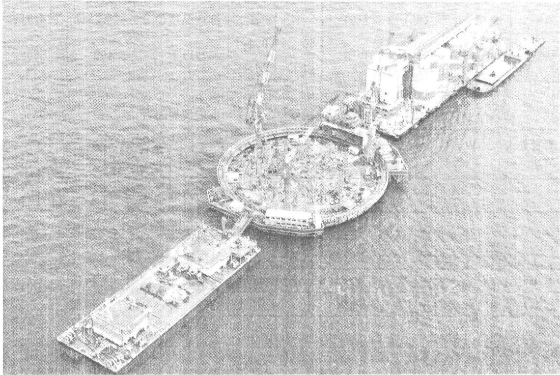
写真-1 明石海峡大橋主塔基礎水中コンクリートの施工状況
