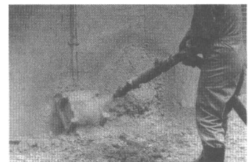
写真-1 吹付け状況
