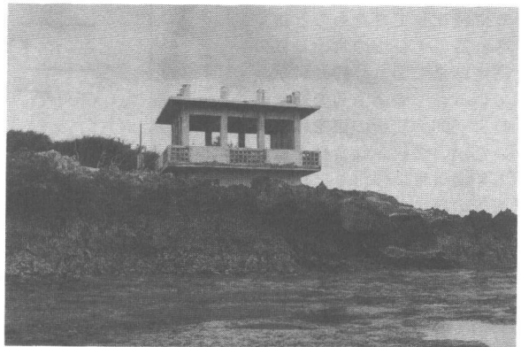
写真-1 暴露構造物の外観
