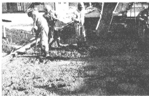
写真-2 PFRCの施工
